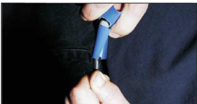
12. odstrániť modré póly zo stopky ťahom a krútením.
