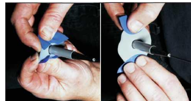
13. Premiestniť poly, ktoré umožňujú ľahšiu manipuláciu počas inštalácie a zabrániť kontaminácii šedej gumy dotykom.
